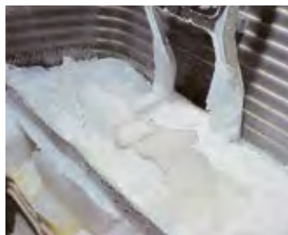
Oblodzenie urządzenia zewnętrznego bez ogrzewania tacy
